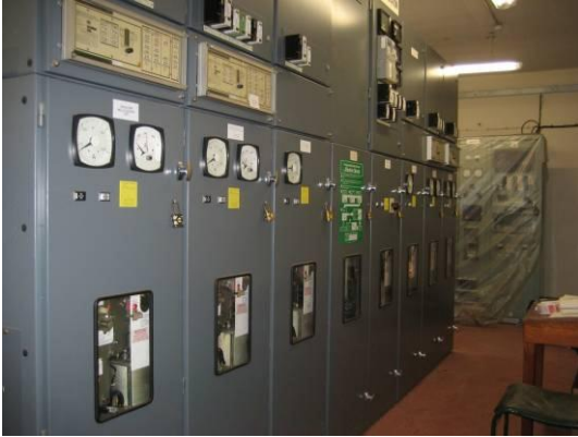
11 kV Switchgear
